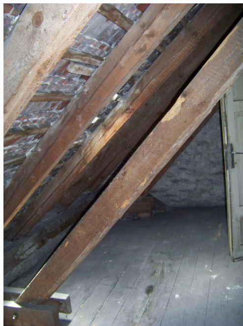
Fot.6.4 Widok uszkodzonego zastrzału
