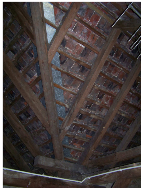
Fot.5.6 Widok krokwi koszowej
