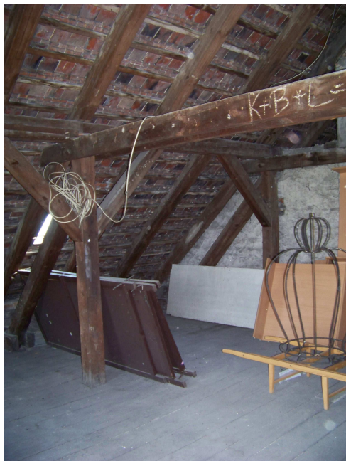
Fot.5.5 Widok ogólny więźby dachowej z zastrzałem
