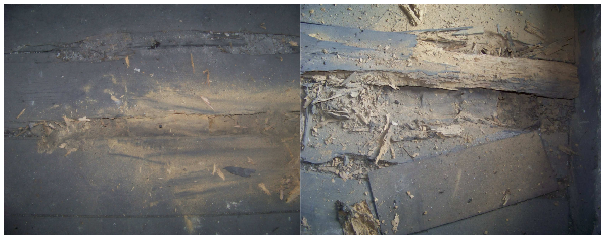
Fot.6.5 Uszkodzenia pokrycia z desek oraz belki nośne
